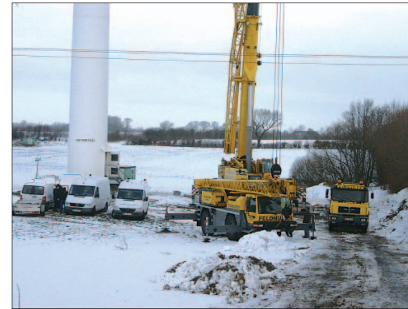
Getriebetausch im Windpark Böel
