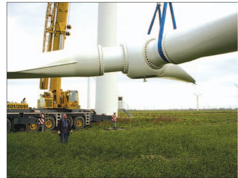
Getriebetausch und Montage im Windpark Sillerup : Die Anlage läuft nach kurzer Zeit wieder.
