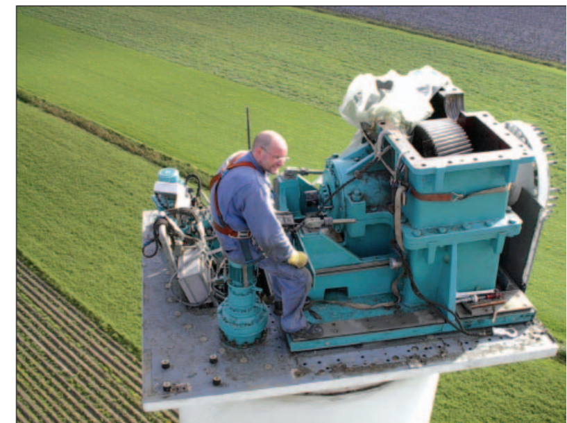
Getriebetausch und Montage im Windpark Sillerup : Die Anlage läuft nach kurzer Zeit wieder.
